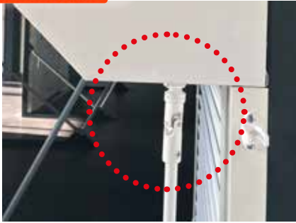
Manivelle de dépannage décrochable
