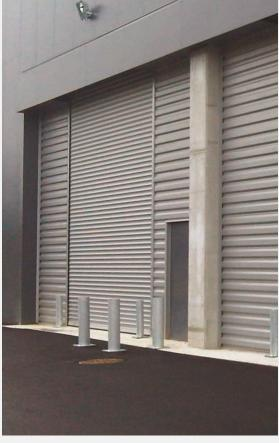
Quand les dimensions augmentent, la rigidité des lames risque d'être mise en défaut. Par leur forme bombée, les lames agrafées du rideau P97 gagnent en rigidité, mais aussi en silence d'enroulement.
