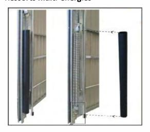
Ensemble: ressorts, avec double protection: la porte ne se décroche pas car elle dispose de plusieurs ressorts, qui sont protégés par un tube de PVC noir.
