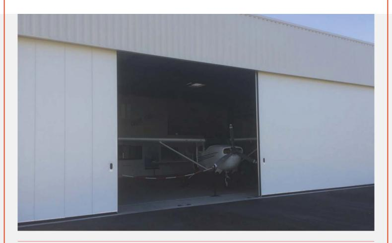
Les portes sectionnelles latérales sont constituées de panneaux nervurés sandwich double paroi de 40 mm, injectés de mousse polyuréthane sans CFC avec un coefficient d'isolation thermique: K = 1,4 W/m².K, permettant d'obtenir robustesse et régidité ainsi qu'une meilleure résistance aux agents atmosphériques.
